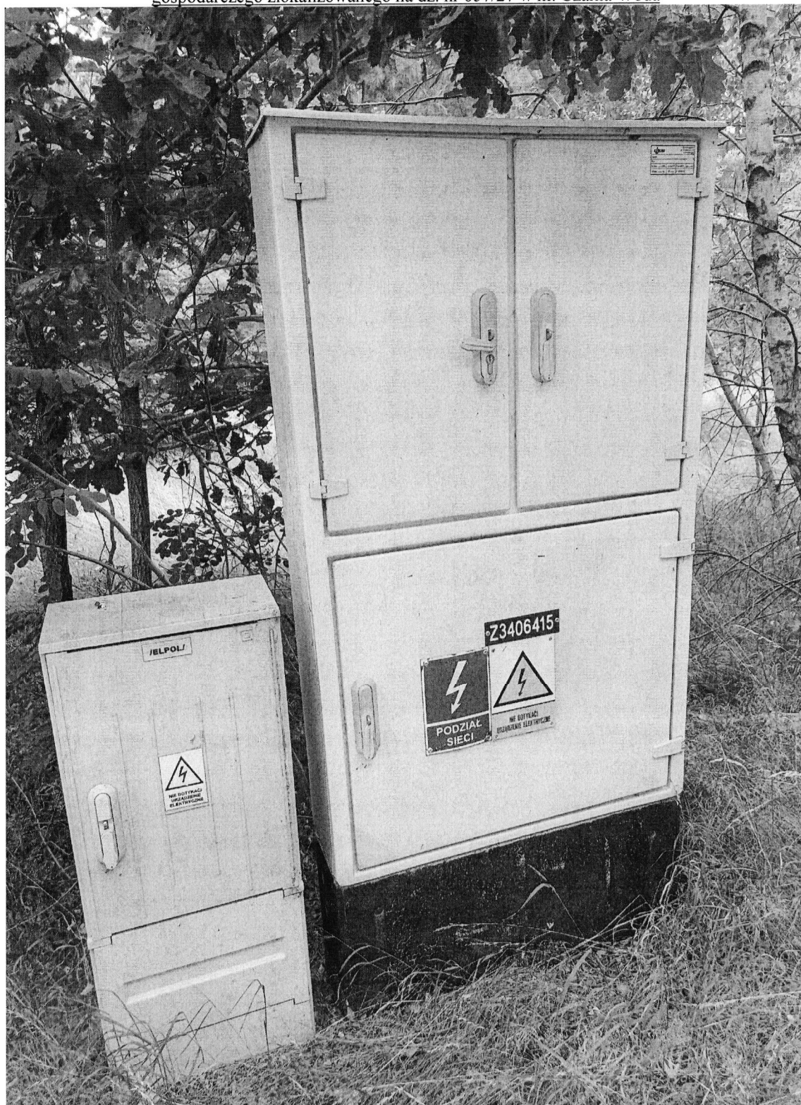
Złącze kablowe Z3406415 obwód 341008-02 (po lewej tymczasówka budowlana)
